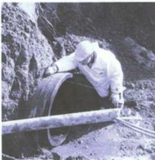
Un operaio Asa al lavoro su una grande tubatura
